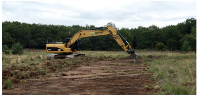
Het lokaal verwijderen van de bouwvoor en het ven uitgraven.
