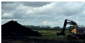
Een tijdelijk gronddepot voor overslag van grond in de vrachtauto.
